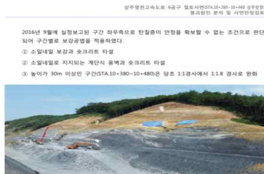
그림 2.16 2016. 12 절토사면 공사 현황
